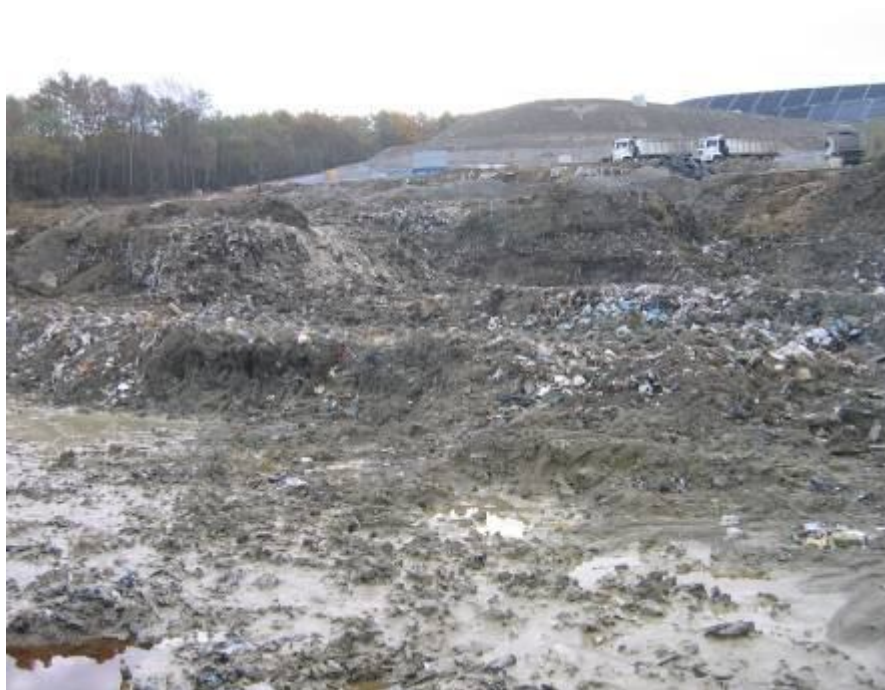
Foto 3: Lavori di bonifica della discarica comunale
