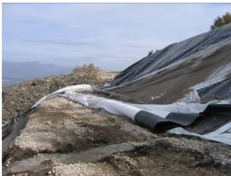
Foto 9: Telo rotto e flesso sulla terz'ultima bancata
