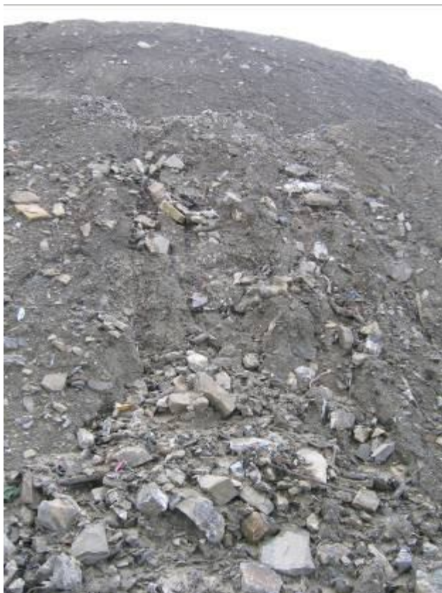
Foto 7: Canali d'incisione provocati dalle acque meteoriche sul versante NE della vasca n°3
