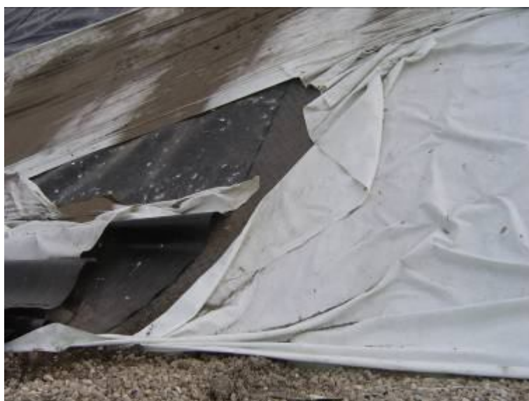
Foto 9: Telo rotto e flesso sulla terz'ultima bancata
