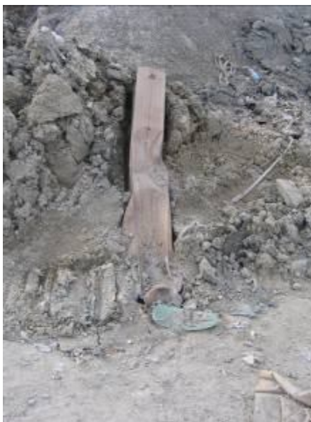
Foto 11: pilastro del cancello abbattuto dai camions
